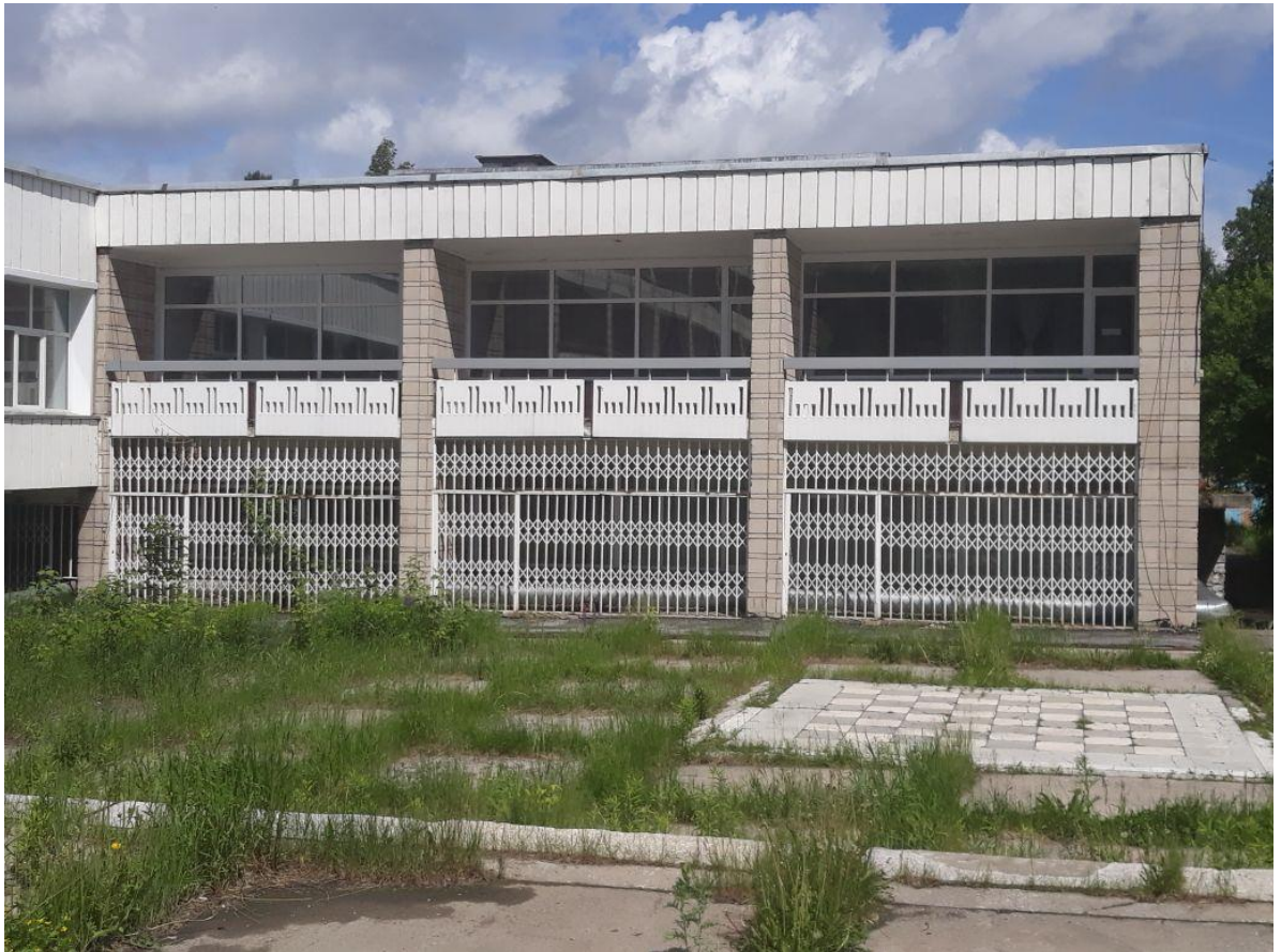
Фотография 2.Фасад в осях 15/А'-Д'
