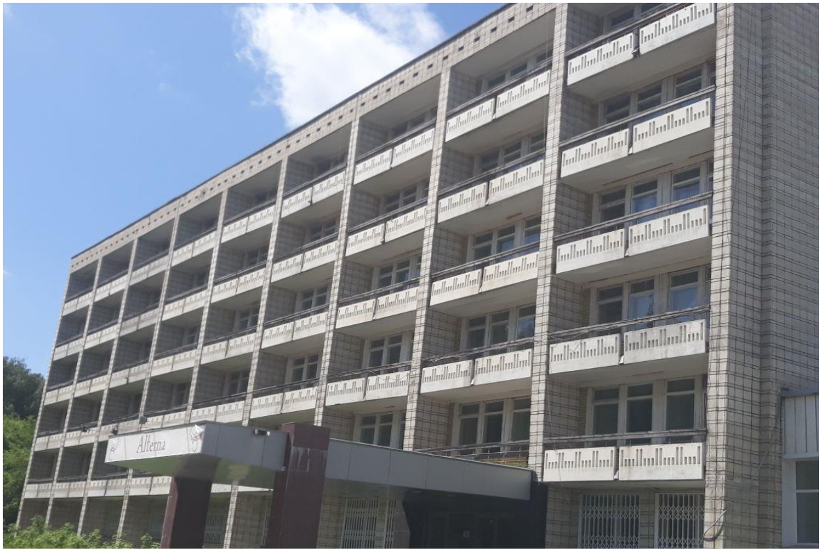
Фотография 1.Фасад в осях 1-15/А'-Д'
