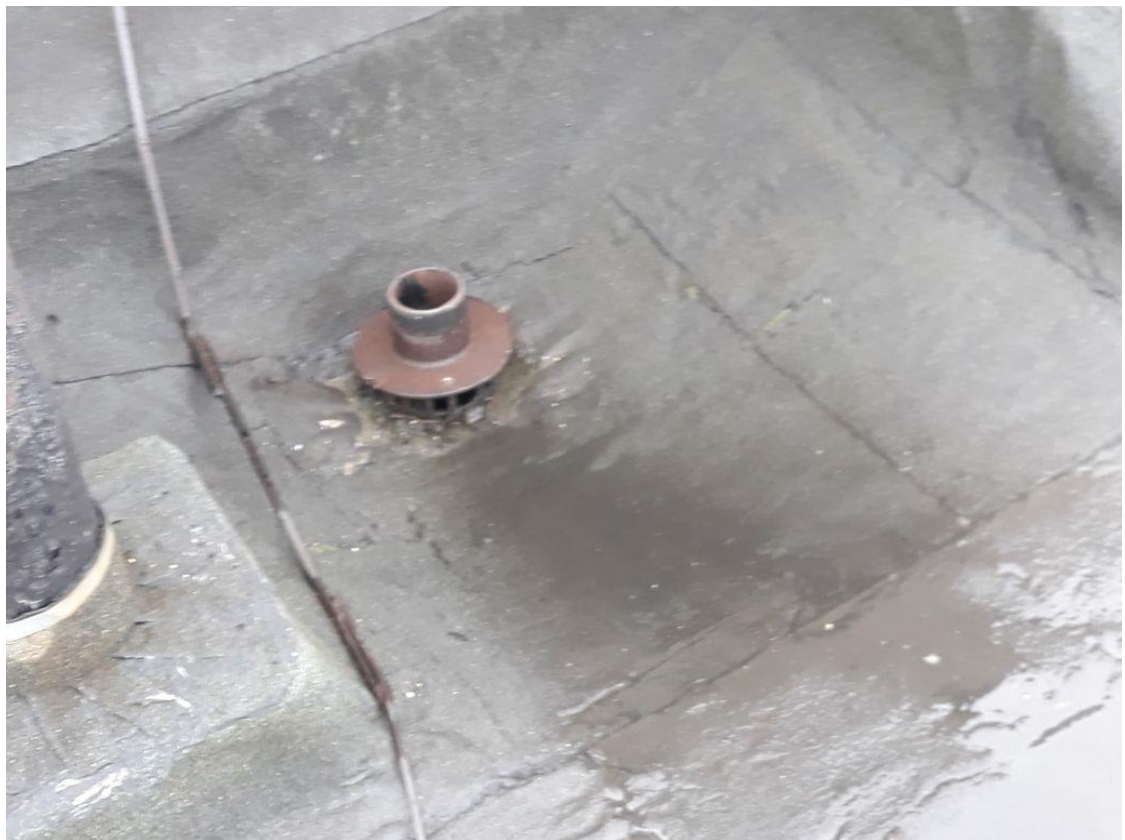
Фотография 14. Водосточная воронка на кровле шестиэтажного корпуса
