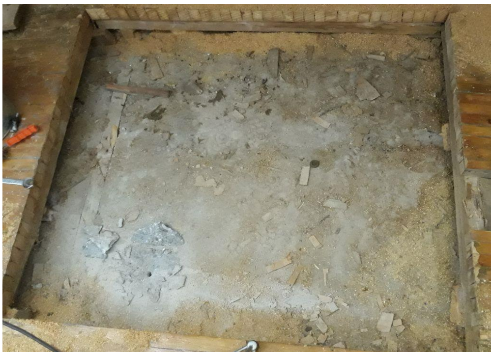
Фотография 33. Вскрытие пола кинотеатра. Бетонный подстилающий слой пола.
