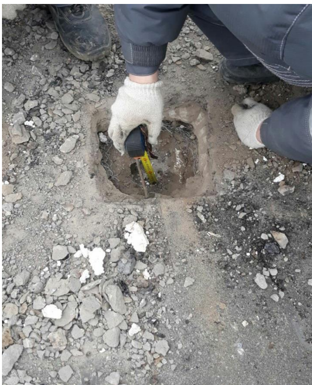
Фотография 27. Вскрытие кровли двухэтажного корпуса
