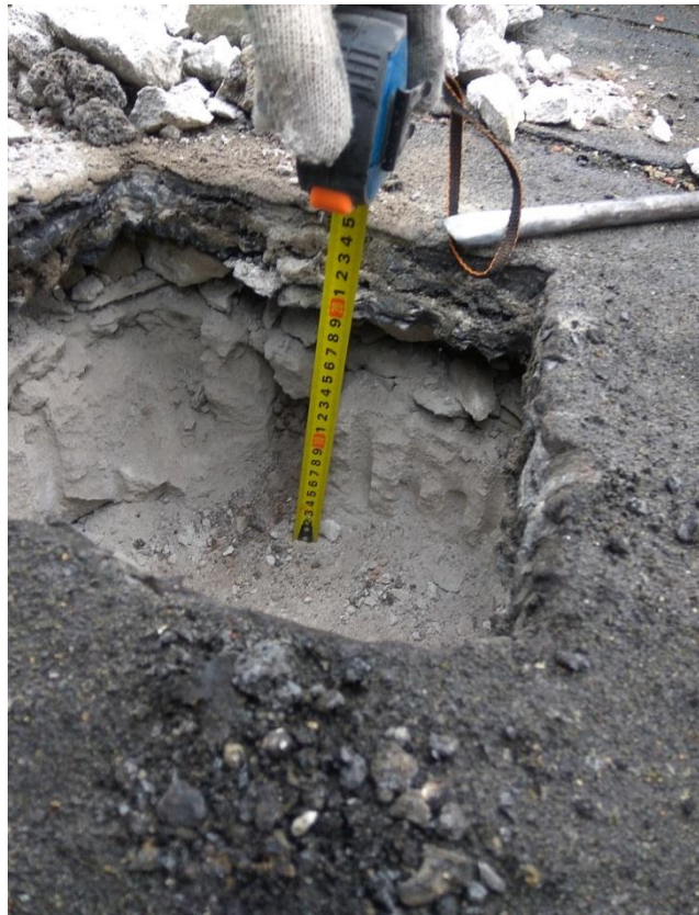
Фотография 6. Вскрытие кровли шестиэтажного корпуса
