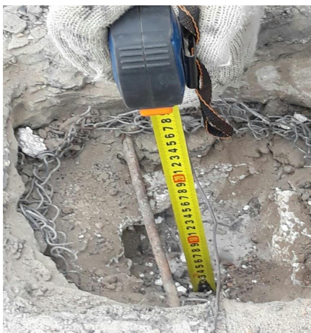
Фотография 28. Вскрытие кровли двухэтажного корпуса
