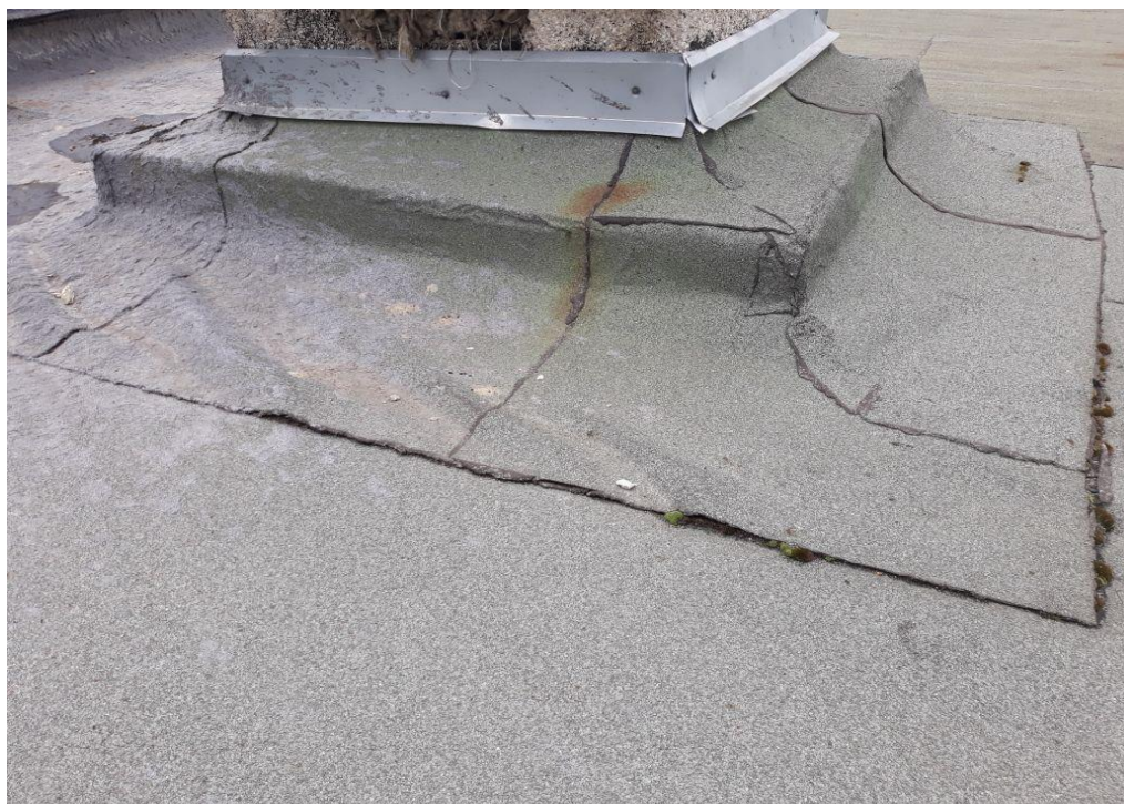
Фотография 20. Примыкание кровли к вентиляционной шахте
