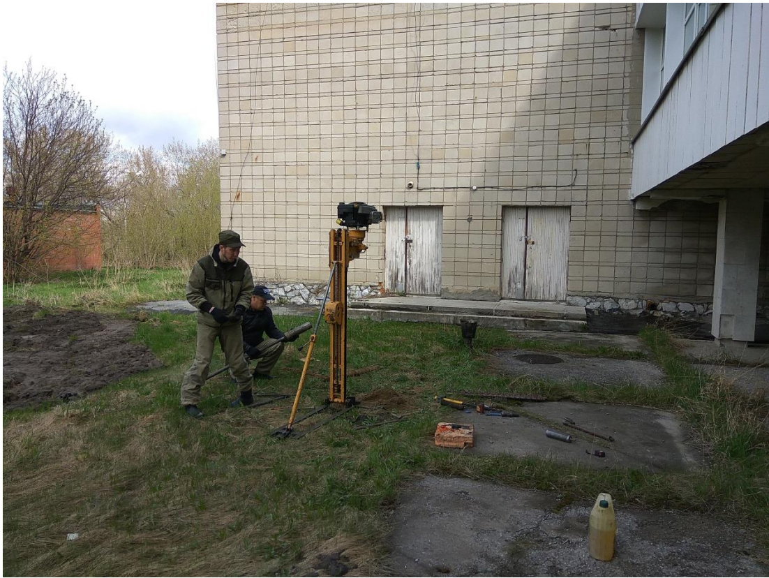
Фотография 43. Бурение скважины
