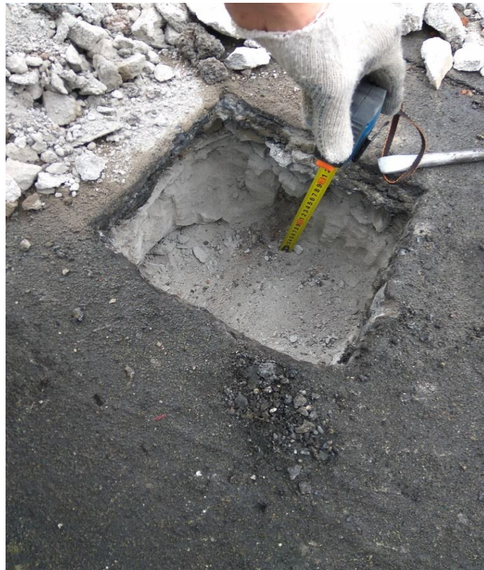
Фотография 7. Вскрытие кровли шестиэтажного корпуса
